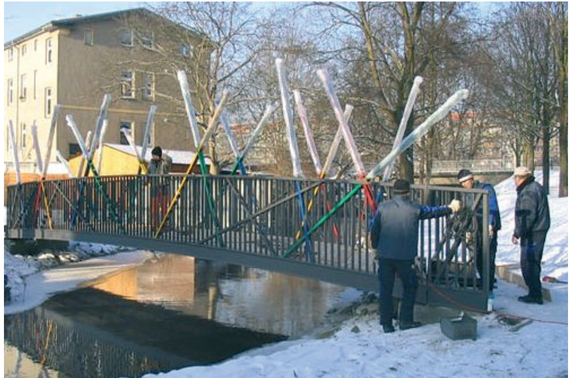
Am 8. Januar 2009 wurde die Brücke über die Schwärze als Auftakt für den neuen Schwärzeparck auf die Widerlager gesetzt. Das Foto zeigt die notwendigen Arbeiten zur Befestigung der Brücke. Die Bauarbeiten für den Spielplatz an der Michaelisstraße beginnen im Sommer.
